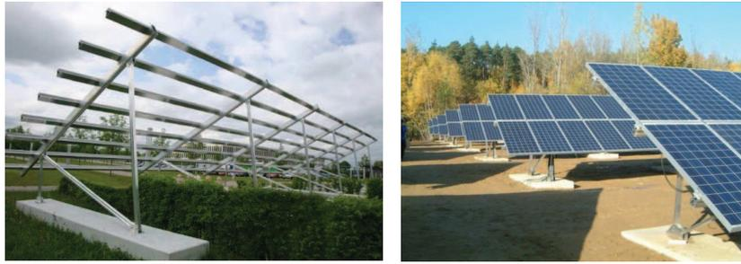
Photo 23 : Exemples de fondations de type « longrines » utilisées pour supporter les structures porteuses
