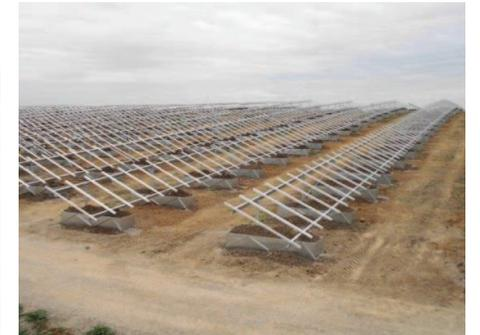
Photo 22 : Exemples de fondations de type « gabions » utilisées pour supporter les structures porteuses
