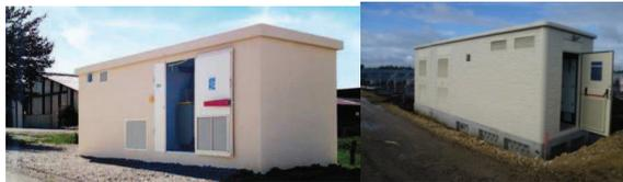
Photo 26 : Exemples de postes de transformation en préfabriqué
