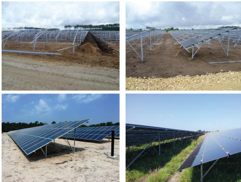
Photo 20 : Exemples de structures porteuses
